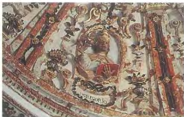
Cúpula de la Iglesia de Benarrabá.
