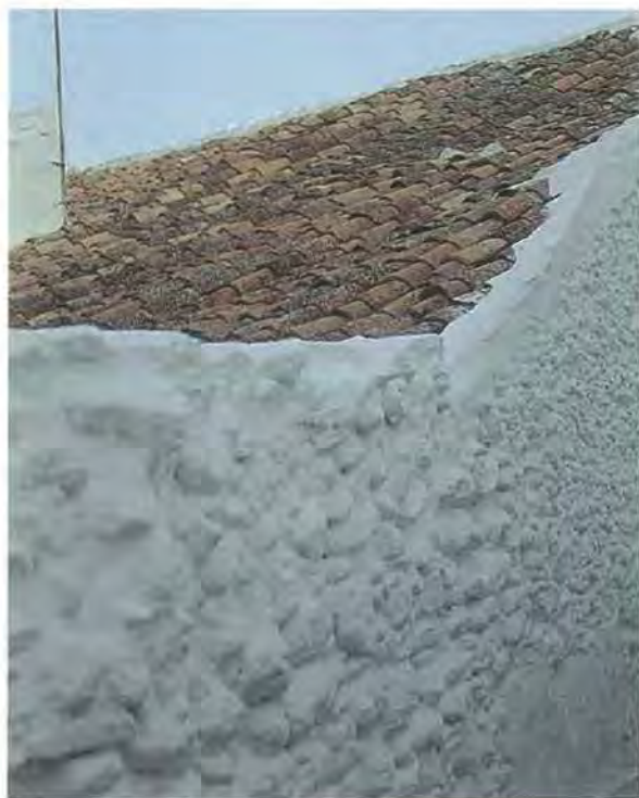
Construcción con muro de piedra.
