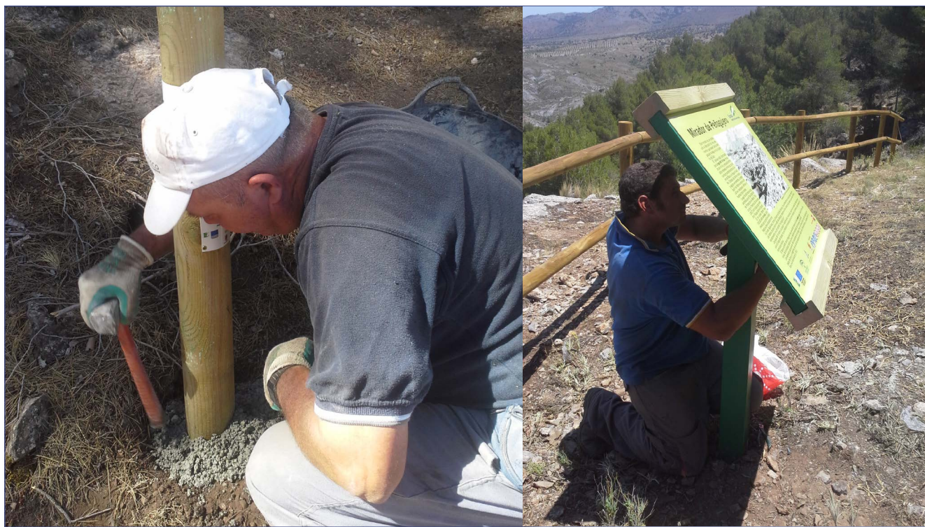
Figura 99: Colocación de Hitos Verticales del Sendero
