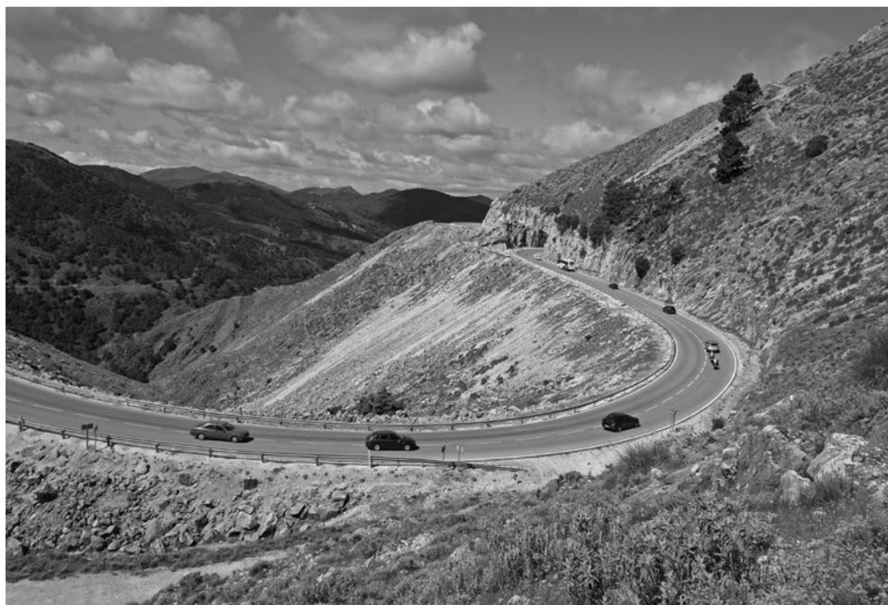
Figura 20. Trincheras y escombreras de la carretera de Ronda a San Pedro de Alcántara a su paso por Sierra Blanca.
