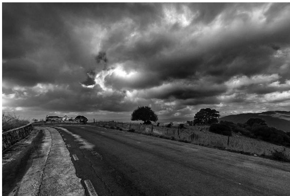
Foto 13. Ruinas del Cortijo del Pollo en la carretera A-377 de San Luis de Sabinillas a Gaucín. En la actualidad esta carretera se encuentra a punto de culminar su rehabilitación del firme
