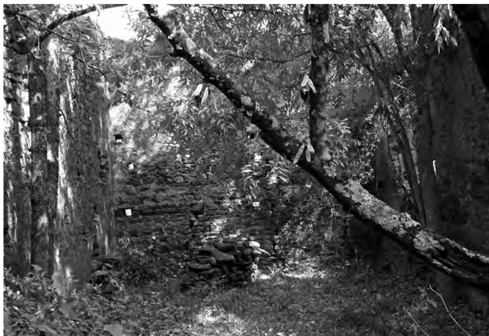
Interior de la antigua iglesia del despoblado de Rotillas (Foto: J. A. Chavarría Vargas)
