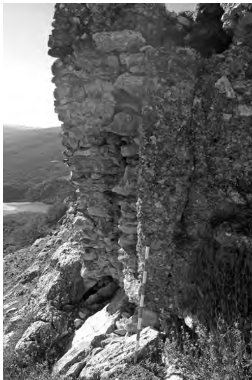
Figura 5. Aljibe y paramento
