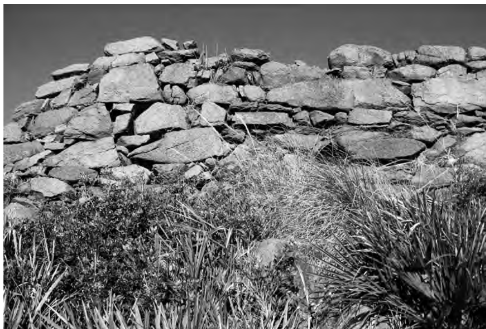
Figura 13. Lienzo de muralla de la fortaleza de Los Castillejos (Estepona)
