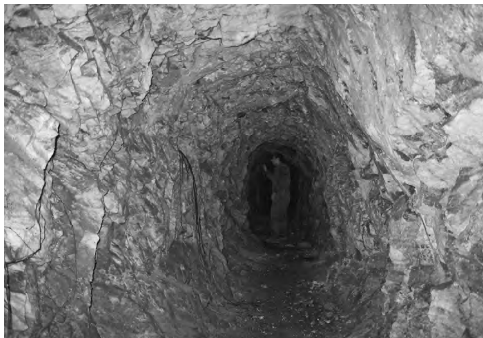
Figura 8. Galerías interiores de la mina Conchita
