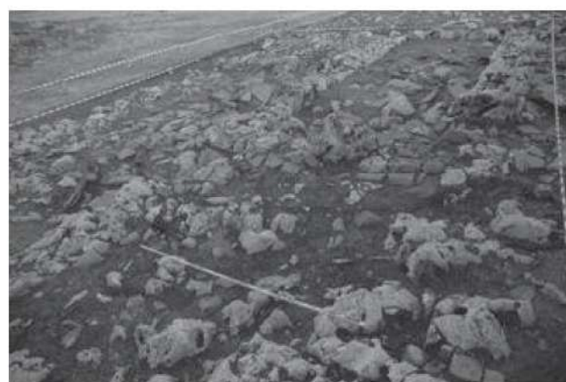
Figura 2. Derrumbes en el sector A.
