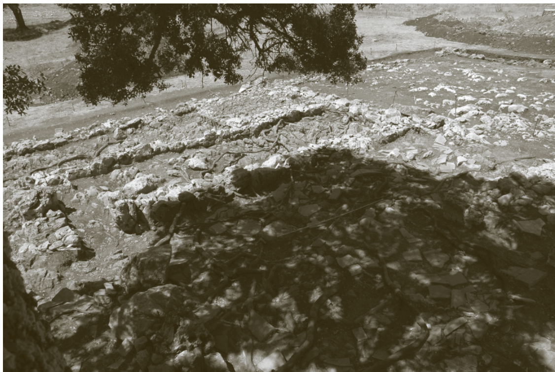
Lám. IV. Vista general de la instalación. Sector B, diáfano (arriba a la derecha), y el sector A, construido
