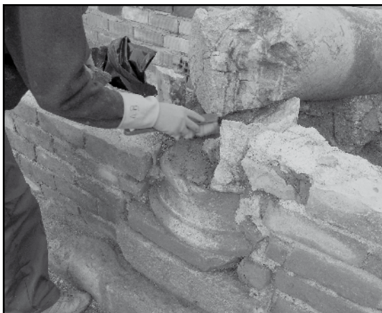
Tratamiento de limpieza en las Termas
