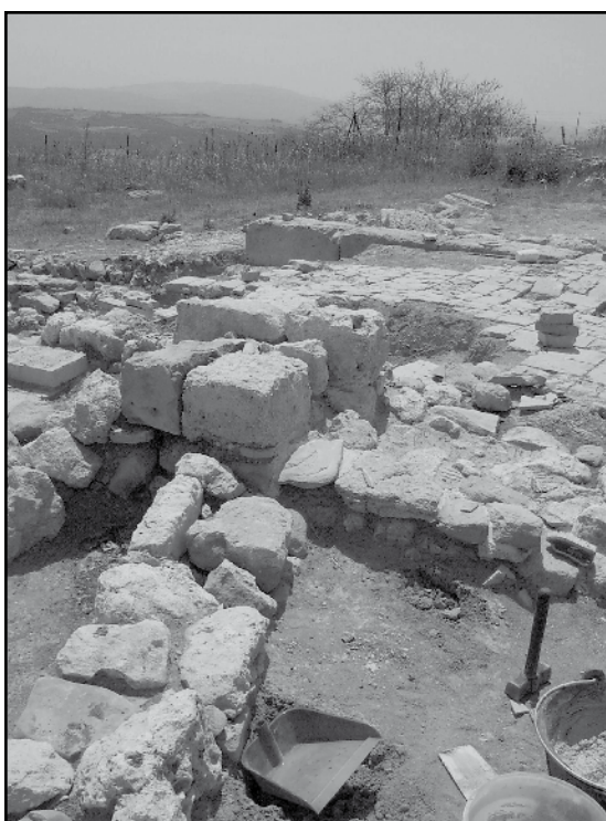
Eliminación de restos de morteros disgregados y erosionados
