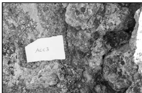
Fig.8 Zona toma de la muestra ACC-3 de Opus Signinum
