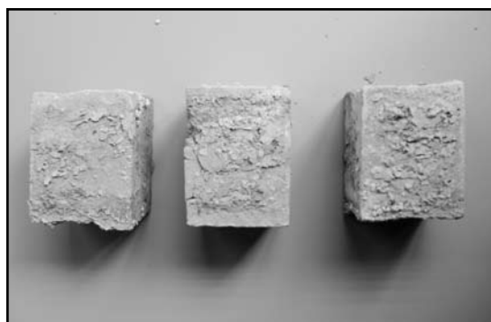
Fig.26. Probetas tratadas con ACRISIL. 5 ciclos. Desconchaduras
