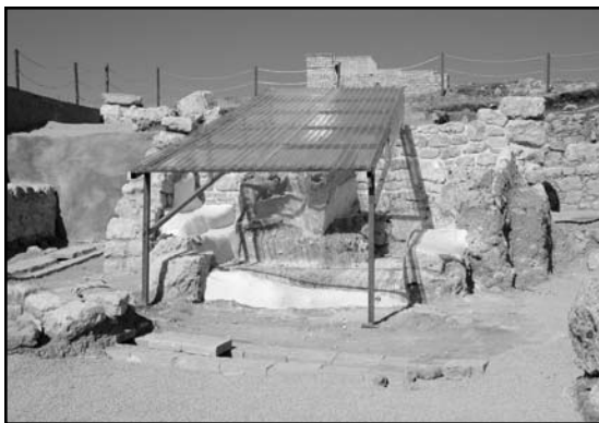
LÁM.LIV: consolidación y protección de la estructura del larario
