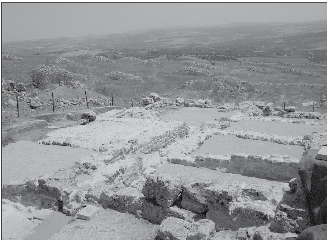
Vista del vallado perimetral y protección del sitio
