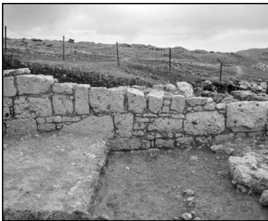
LAM.LXII: detalle de la fábrica del muro de la crujía norte
