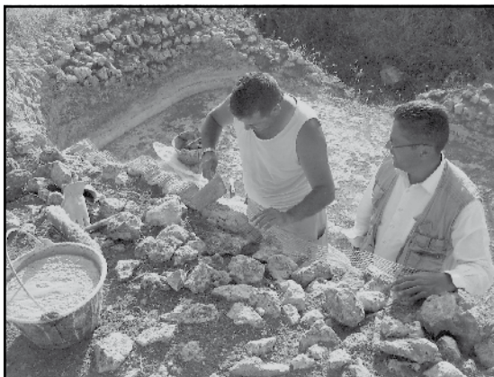
Reintegración volumétrica, estableciendo el criterio diferenciador al superponer una red
