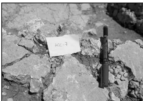
Fig. 11. Punto extracción de la muestra ACC-7. Hormigón de cal
