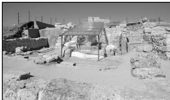
LÁM.LIII: consolidación y protección de la estructura del larario
