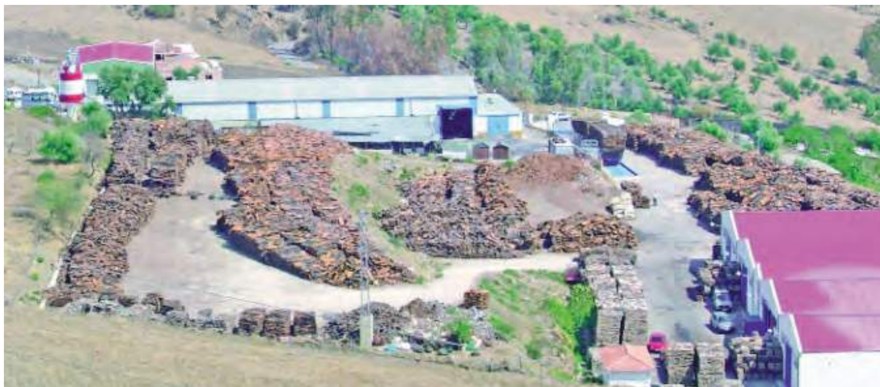
Centro de recolección y transformación del corcho en Cortes de la Frontera
